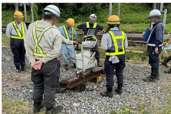
レール探傷合同訓練
