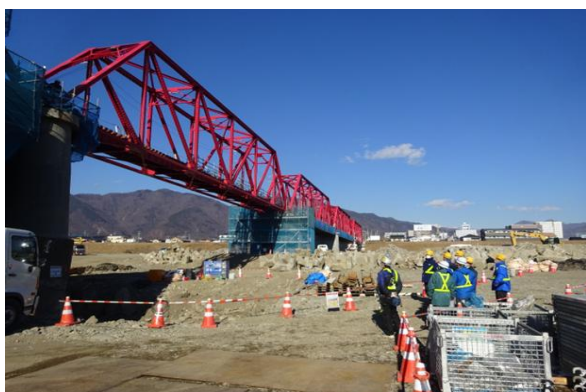
災害復旧工事現場視察及び意見交換
