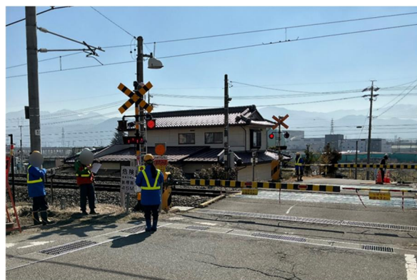
異常時対応を想定した訓練
