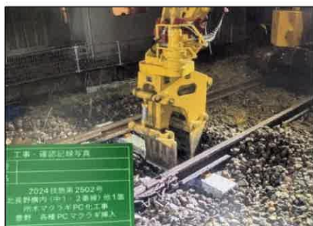
▲ PC マクラギ化工事
