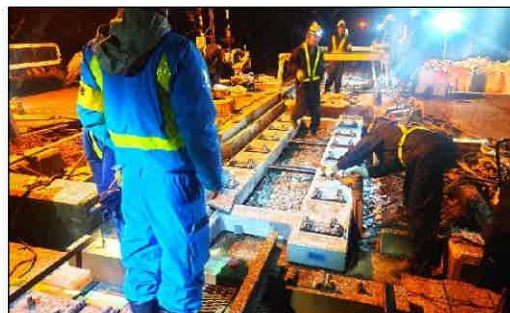
▲交換工事風景
