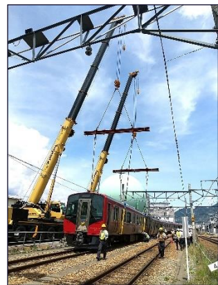
▲クレーンによる載線作業
