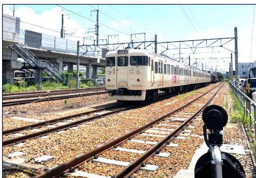
▲軌道構造強化が完了した上田駅電留線
