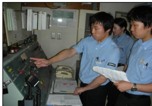
【駅補助制御盤取扱い訓練】
