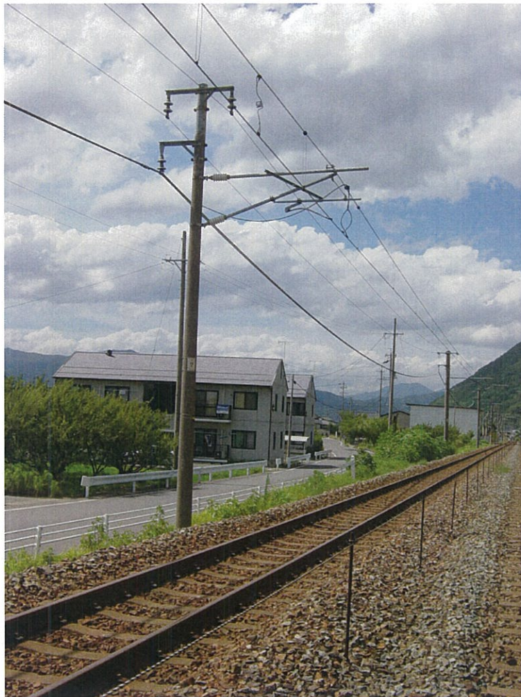
写真 1. 施行箇所（全景）
