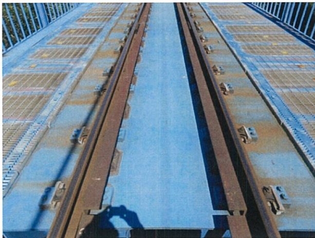
写真1. 施行箇所（全景）
