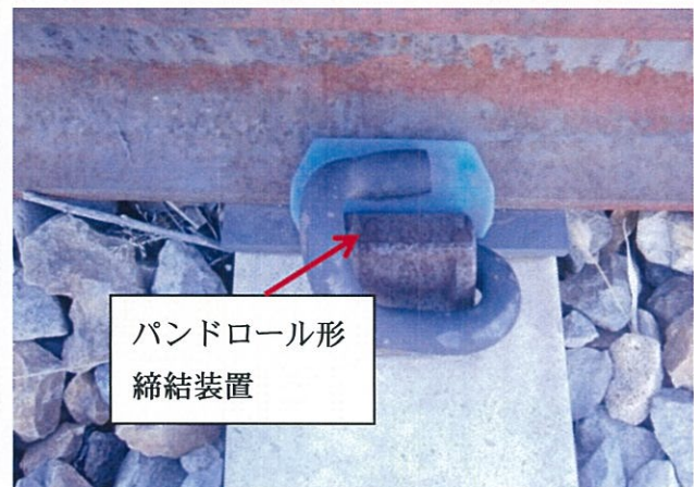
写真 3. 更新後の締結装置（パンドロール型）
