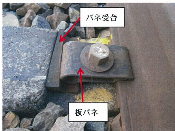
写真 2. 更新前の締結装置（6号9型）
